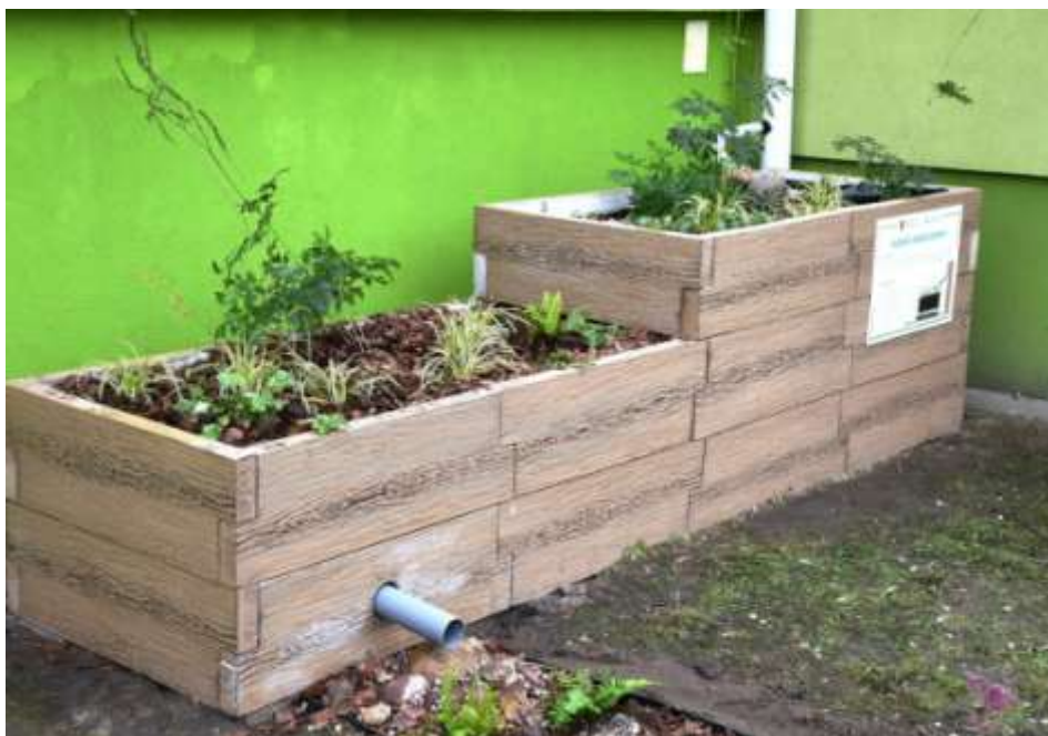
Rys.7. Ogród deszczowy w pojemniku.
